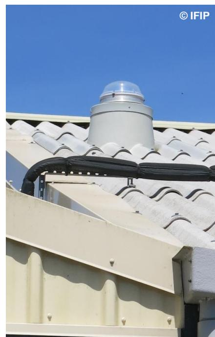
Puits de lumière dans la salle, cheminée dans les combles pour conduire la lumière depuis la toiture et globe positionné au faîtage pour capter les rayons du soleil
